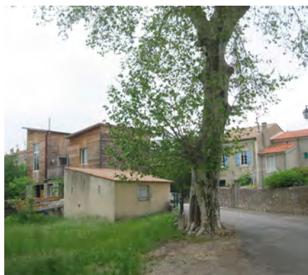
Surélévation d'une ancienne remise en pierre, à Saint Bauzille-de-Putois (34), architecte inconnu
