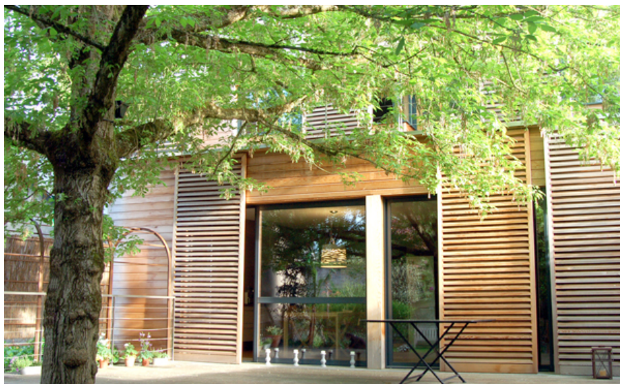
Extension à Angers (49), architecte Pascale Minier
