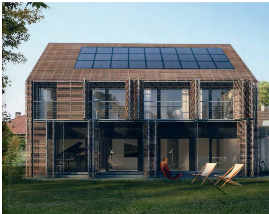
Construction d'une maison passive à Bessancourt, architectes M. Karanesheva et M. Witzmann Les capteurs solaires, thermiques et photovoltaïques sont intégrés en toiture dans un traitement homogène.
