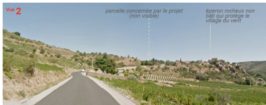
Depuis la route venant de l'Ouest, le village ancien et ses premières extensions sont complètement masquées : ce versant exposé au vent n'a pas été bâti et sert de protection naturelle aux constructions.
