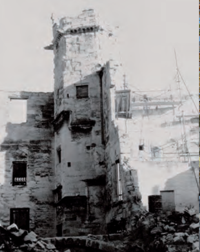
Hôtel de Roche, una casa di città nella via Paul Foussat, prima del restauro.
