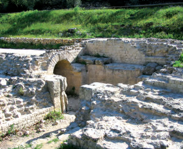
Bacino di regolazione dell'acquedotto romano nella valle dell'Eure. Permetteva di modulare la portata dell'acqua nella canalizzazione inviando l'acqua in eccesso verso l'Alzon e di chiudere l'acquedotto per la pulizia e la riparazione.
