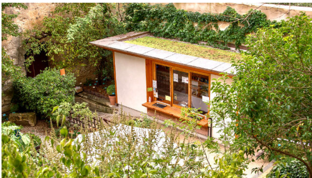
Le pavillon d'accueil, billetterie rénové du Jardin médiéval d'Uzès, aboutissement du chantier école mené sur quatre ans et subventionné par l'Union européenne, l'association In Situ et la Ville d'Uzès en partenariat avec l'association Pistes. Photo : Patrick Henry, Jardin Médiéval d'Uzès
