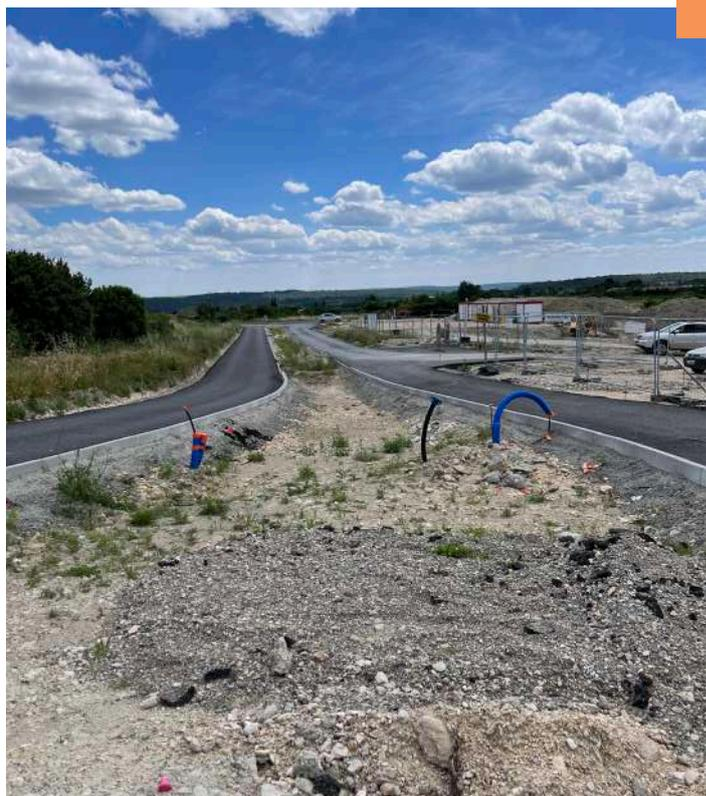
Avant de commencer les travaux du bâti, la commune a réalisé d'important travaux de viabilisation et a du réaliser la création de la voie de desserte.
