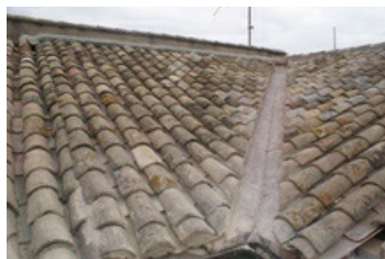
De nouvelles noues en cuivre - arêtes rentrantes formées par la rencontre des versants de deux toits - ont remplacées les anciennes.
