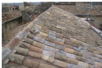
La toiture de l'Hôtel de Ville, côté est, rénovée
