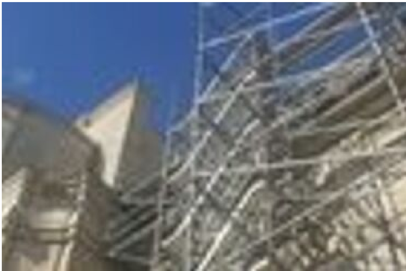
L'église Saint-Etienne en travaux
