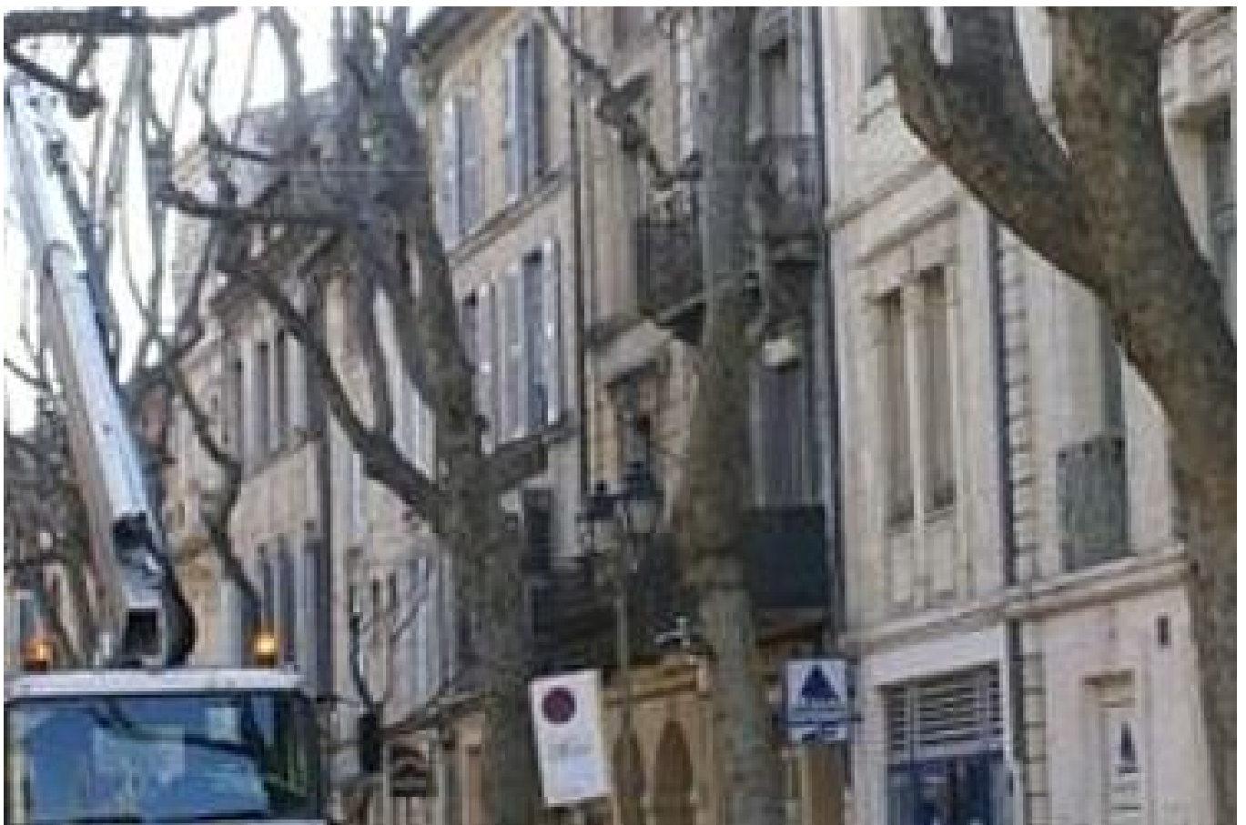
Travaux : élagage des arbres en cours
