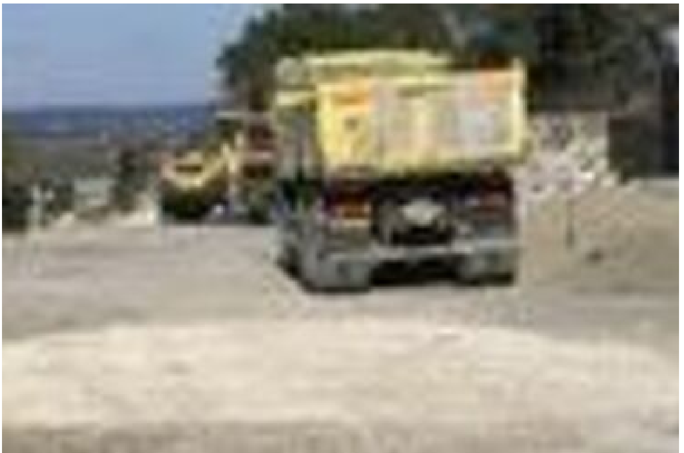
Travaux en cours au parking du Serrebonnet
