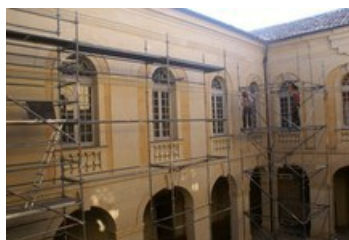
Montage des échafaudages
