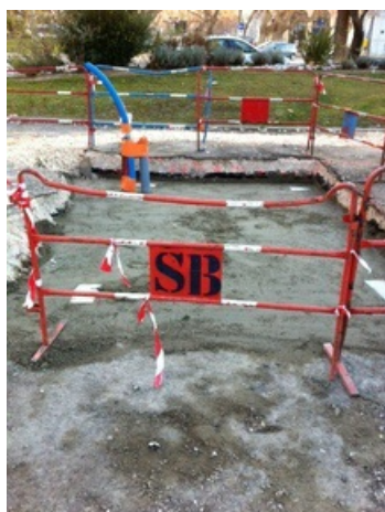
Les futures toilettes publiques seront situées sur le parking de l'avenue de la gare
