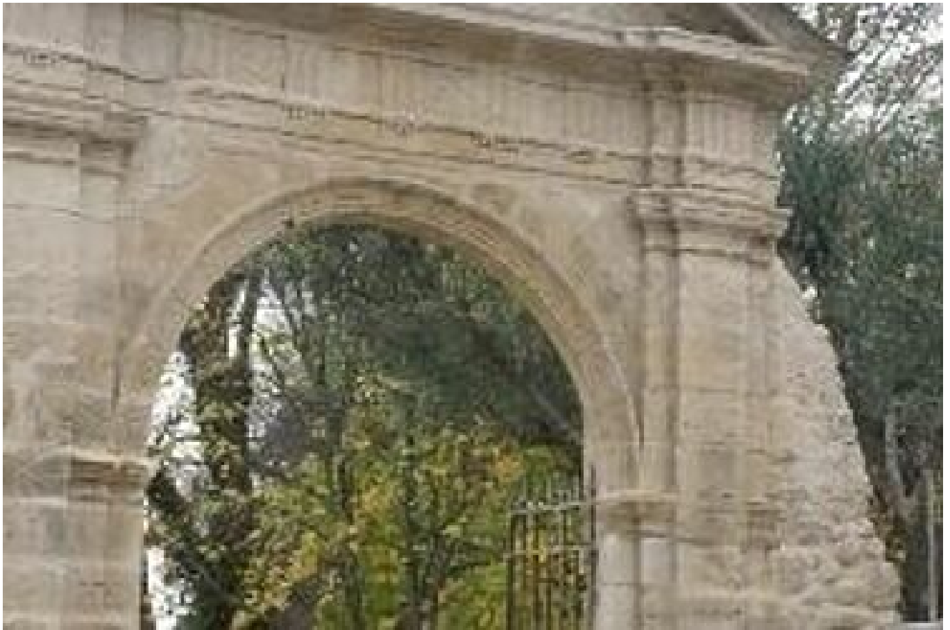
La porte d'entrée du parc du Duché entièrement rénovée
