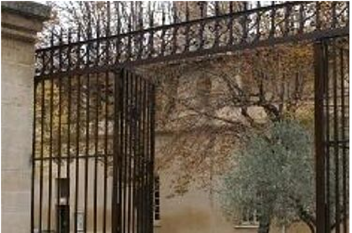
Le portail du temple d'Uzès entièrement restauré
