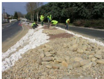
Pont des charrettes : les élèves du Grand Mas, réalisant la première partie de l'aménagement, une rivière sèche, qui sera livrée fin avril
