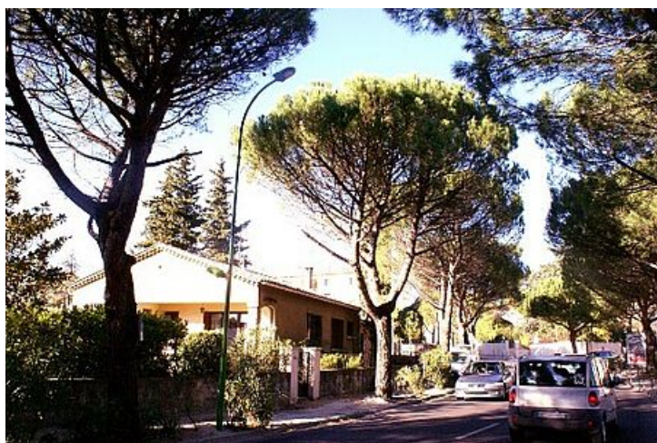
Avenue Georges Chauvin : nouvel éclairage public et réfection des trottoirs
