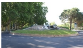
Fontaine de l'esplanade, en cours d'aménagement
