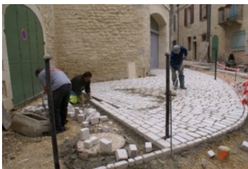
L'entreprise Lautier Moussac intervient sur la pose des pavés de la rue petite Bourgade
