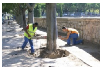
La société Lautier Moussac est mandatée par la mairie pour les travaux
