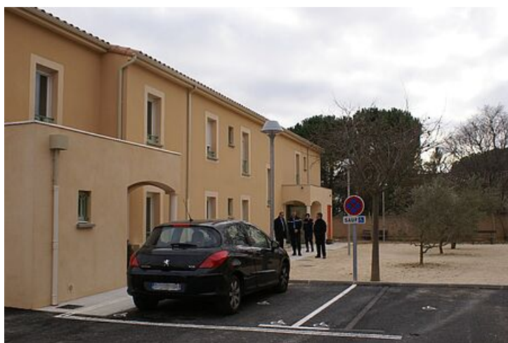
Cinq nouveaux logements construits
