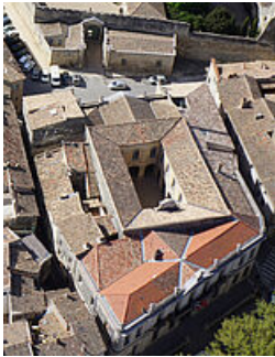
Lancement de la 6e tranche des travaux de couverture de l'Hôtel de Ville, côté boulevard Charles Gide et rue du Salin. Photo : Drone Aero Services
