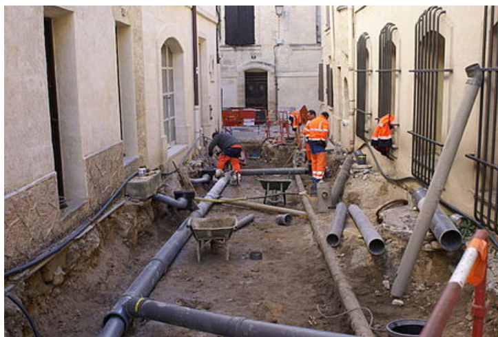
Rue Saint Roman en cours de réhabilitation
