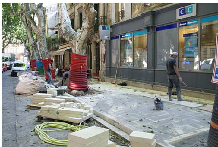
Boulevard Gambetta en cours de pavage. Fin du pavage et de la phase 1 au 31/05/2018
