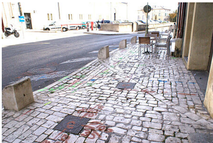
Marquage pour repérer les réseaux enterrés, boulevard Charles Gide à Uzès
