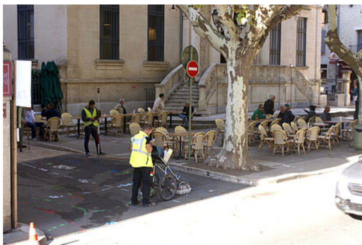
Relevés topographiques et marquage au sol destiné à préparer le futur chantier de rénovation des trottoirs, centre ancien d'Uzès
