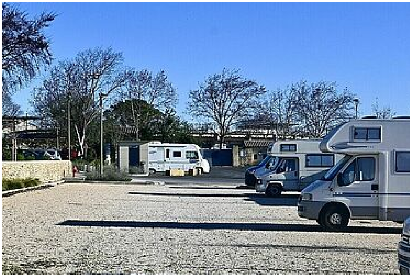
Réaménagement du Parking du Refuge
